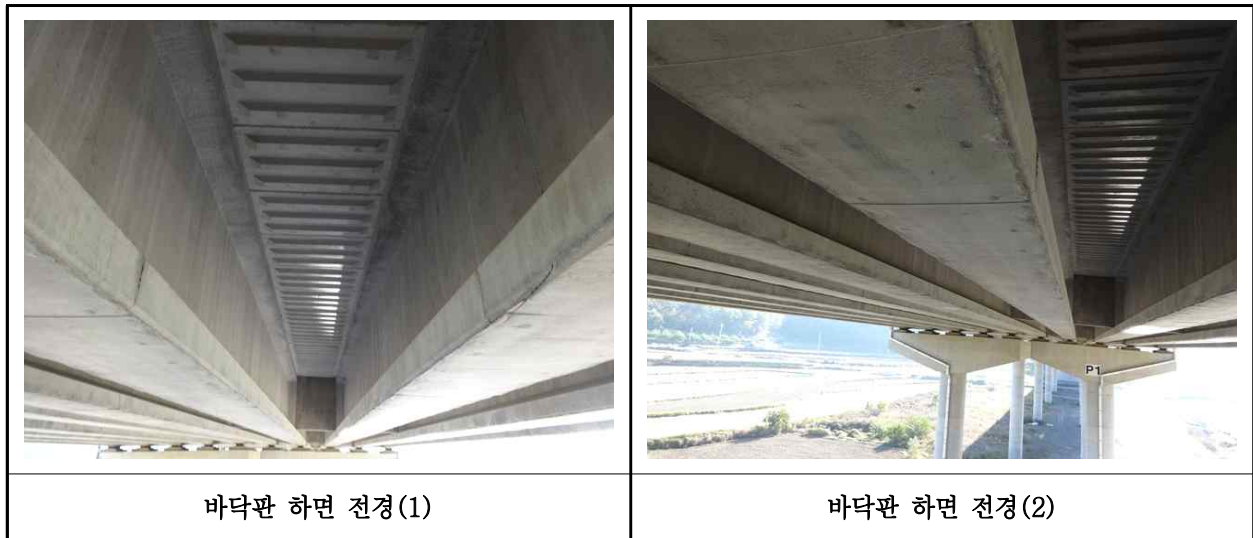
【사진 31.3.25】바닥판하면 전경
