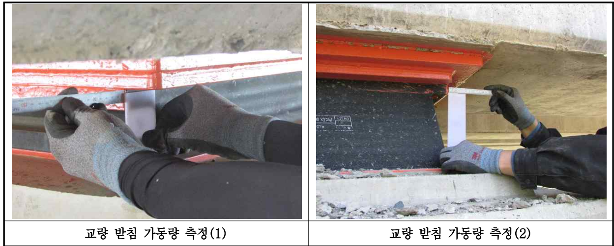
【사진 31.3.38】 교량받침 이동량 측정
