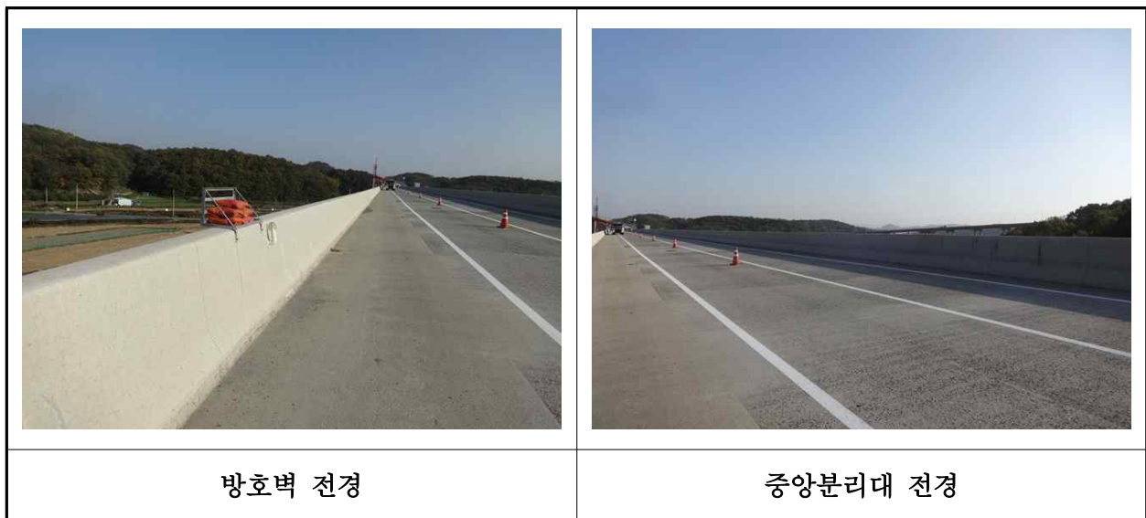
【사진 31.3.23】 방호벽 및 중앙분리대 전경
