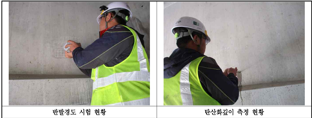
【사진 31.4.1】 콘크리트 내구성조사 현황
