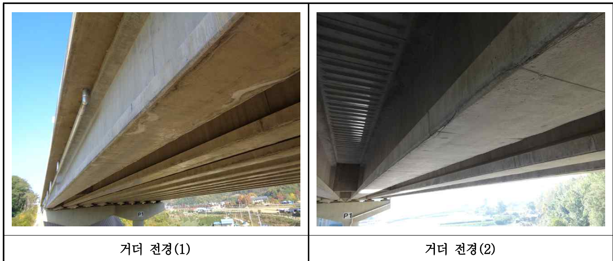
【사진 31.3.27】 거더 전경
