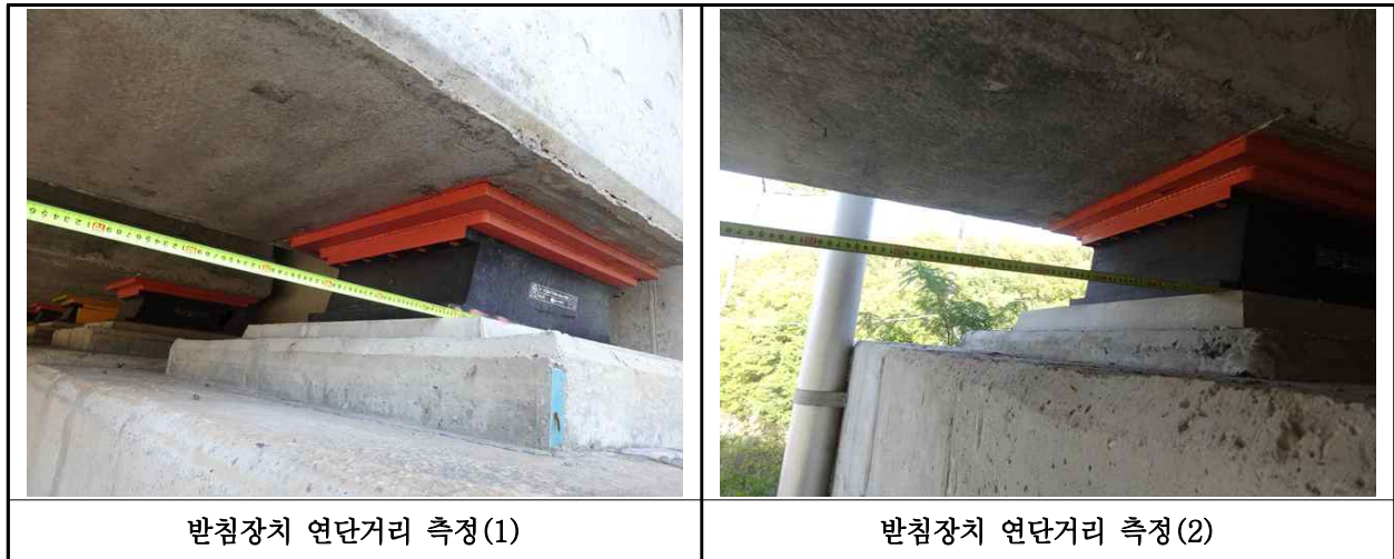
【사진 31.3.14】교량받침장치 연단거리측정
