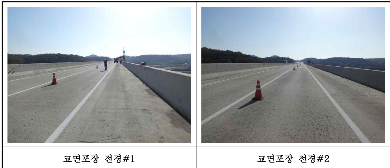
【사진 31.3.42】 교면포장 전경
