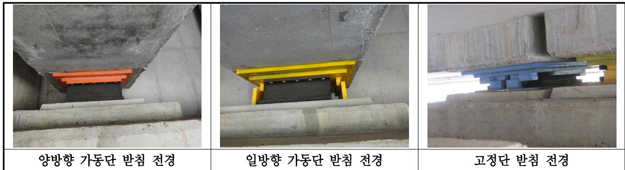
【사진 31.3.12】 교량받침 전경
