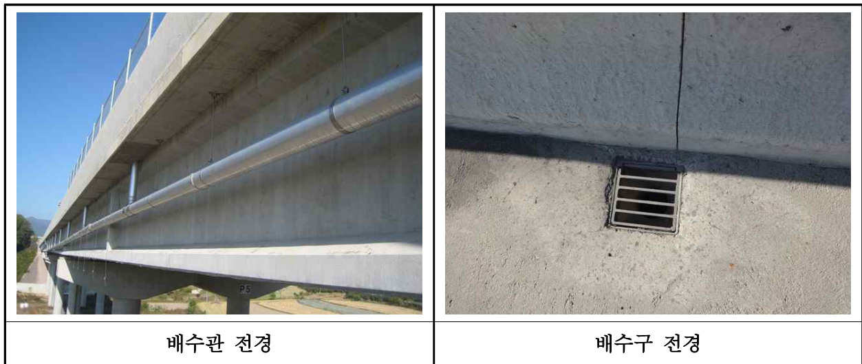
【사진 31.3.44】 배수시설 전경
