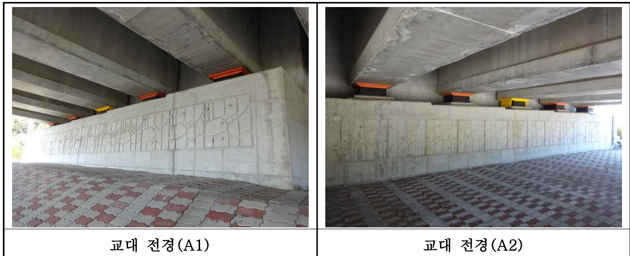
【사진 31.3.31】 교대 전경
