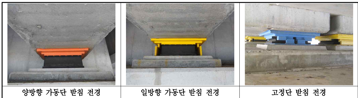
【사진 31.3.35】 교량반침 전경
