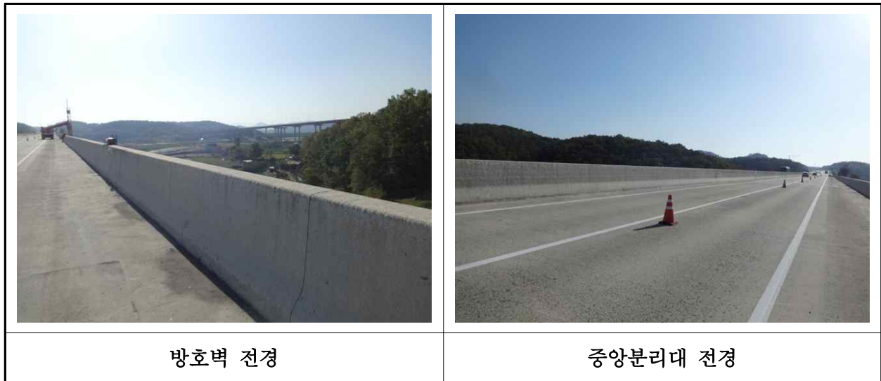
【사진 31.3.46】 방호벽 및 중앙분리대 전경
