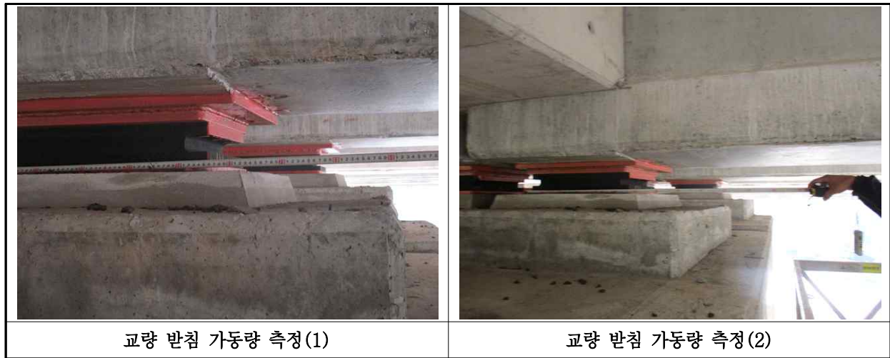
【사진 31.3.15】 교량받침 이동량 측정
