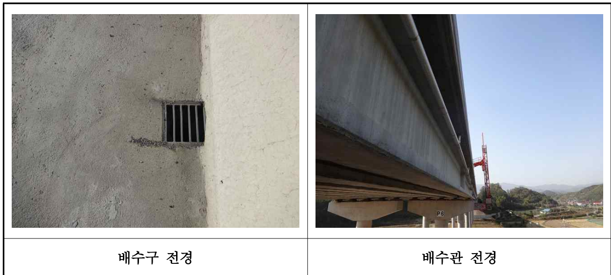
【사진 31.3.21】 배수시설 전경
